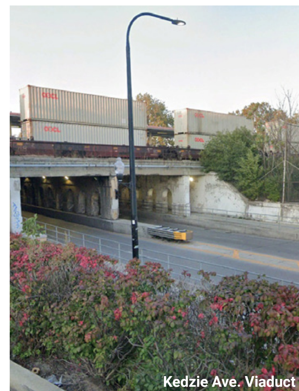
Kedzie Ave. Viaduct
